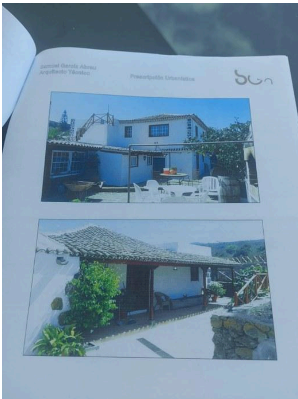
Vista del patio interior y del pórtico de acceso con cubierta de teja cerámica curva. Fotografías del reportaje fotográfico adjunto a la Prescripción Urbanística emitida por el Arq. Técnico Samuel García Abreu en mayo de 2017, confirmando el estado de conservación del inmueble en esa fecha.
