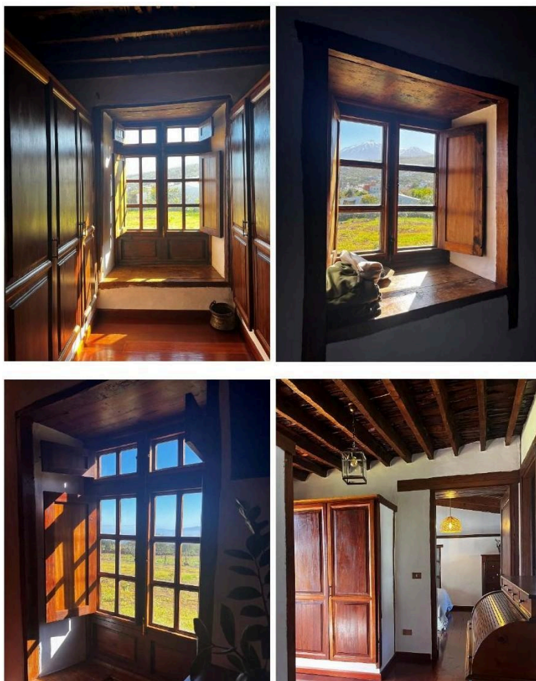
Carpinterías de madera con asiento interior y contraventanas de despiece tradicional, estructura de cubierta interior. Fotografías: Informe Arq. J.Y. Santos Santana, marzo 2026.
